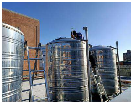
定期清洗水塔
